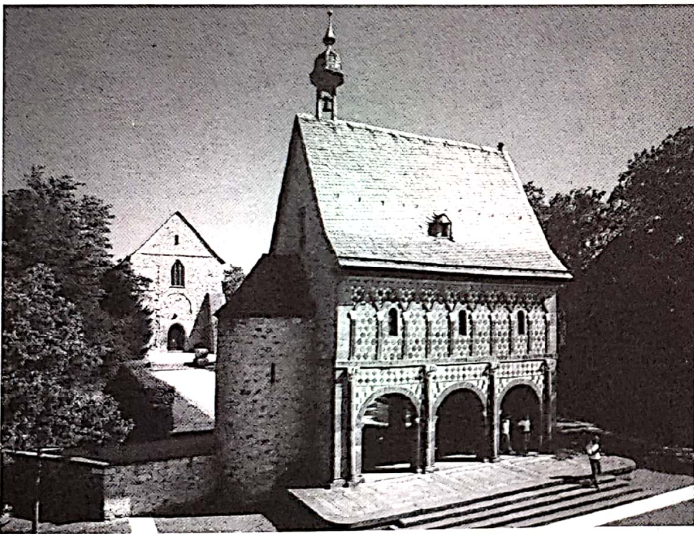
Erhaltene Reste des 1621 zerstörten Klosters Lorsch: vorne die sogenannte „Königshalle“, hinten die Vorkirche.
